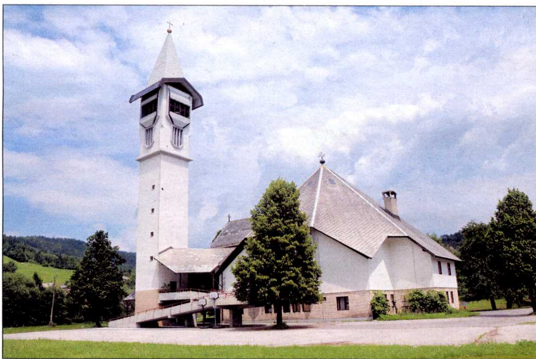
Novo cerkev v Poljanah je župnik Miro Bonča v letih od 1965 do 1970 moral zgraditi na poplavnem območju
